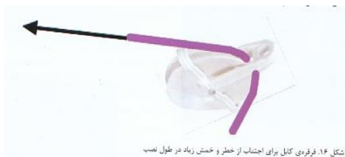
شکل ۱۶. فرقره ی کابل برای اجتناب از خطر و خمشی زیاد در طول نصب
